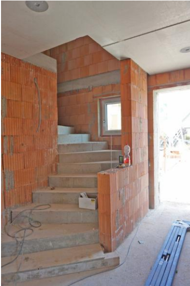
Auch die Treppe ist massiv
