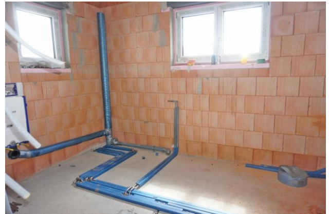
Hier entsteht das Bad
