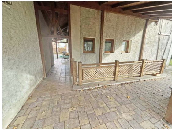
Überdachter Bereich mit Durchgang zur Einfahrt
