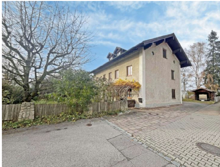
Ansicht von der Straße aus
