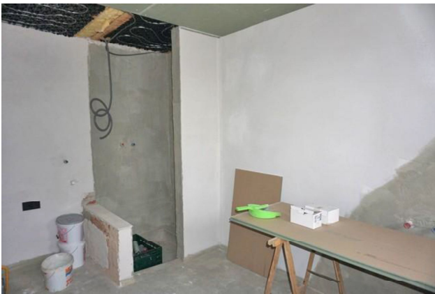
Bad OG (Renovierung begonnen)
