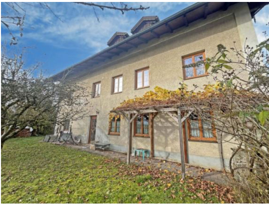
Südansicht des Hauses
