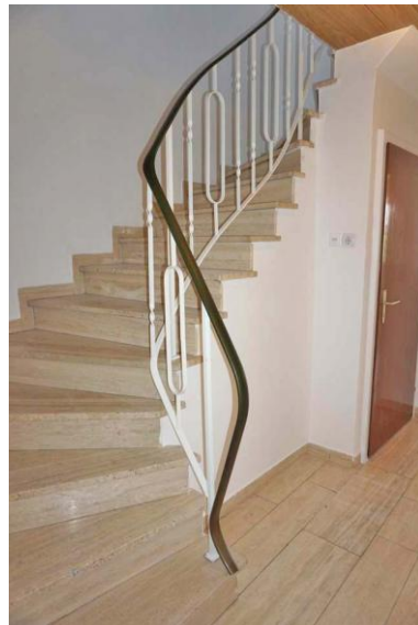
Treppe vom EG in das OG
