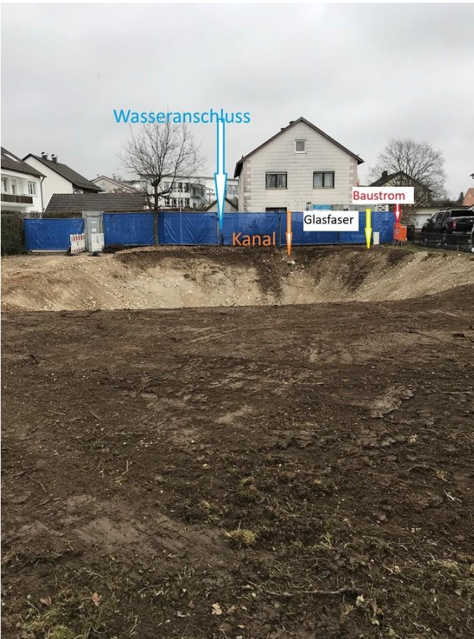
Baugrube und Sparten
