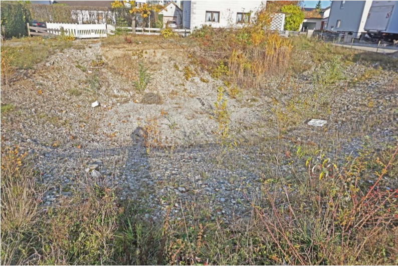
Blick auf die Baugrube
