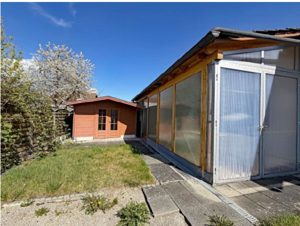
Gerätehaus und geschützter Eingang
