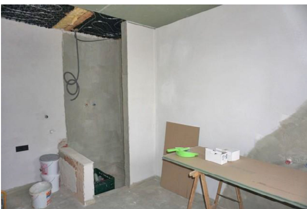
Bad OG (Renovierung begonnen)
