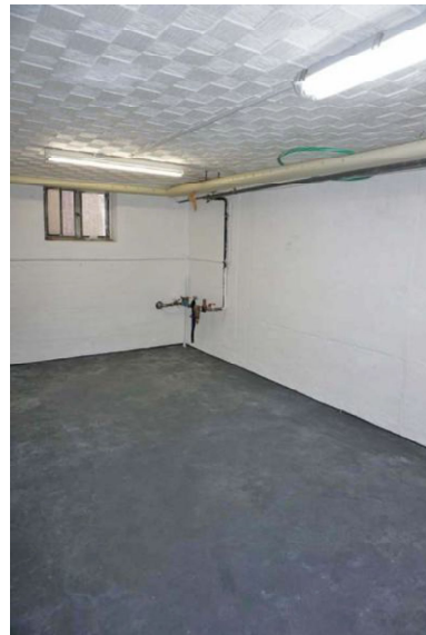
Raum 1 im Keller
